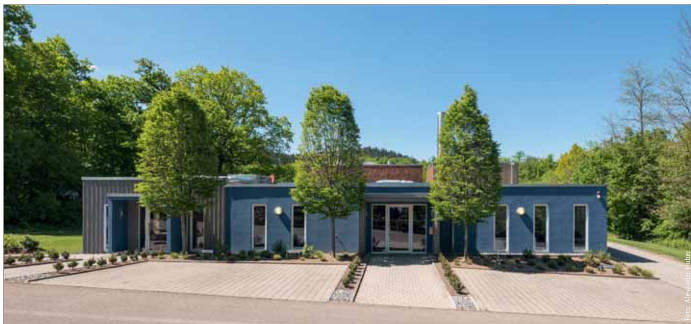
Das Krematorium in Schwäbisch Hall.
